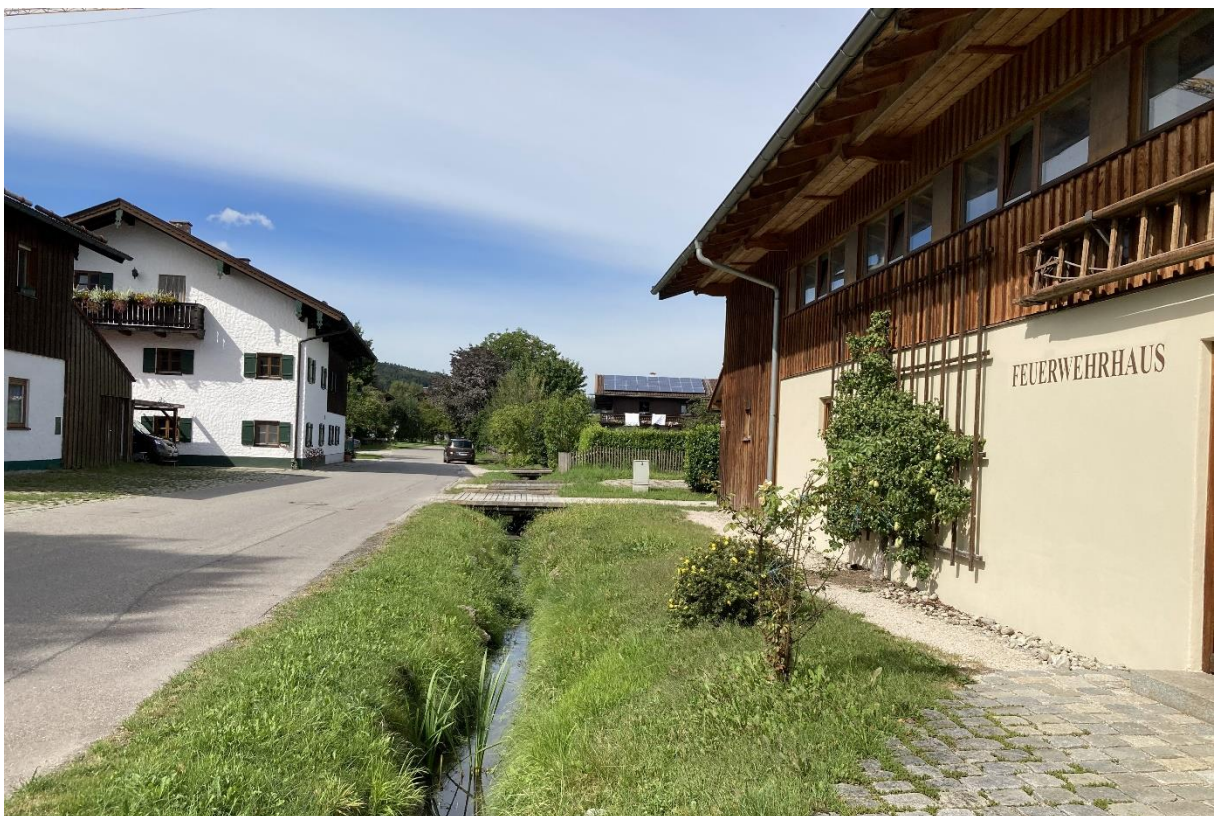
Abb. 9 Bachrenatierung des Kotbachs vor dem Feuerwehrhaus (Hauptstraße 10) außerhalb des Planungsgebiets im Westen (Bestandsaufnahme 25.08.2020)
