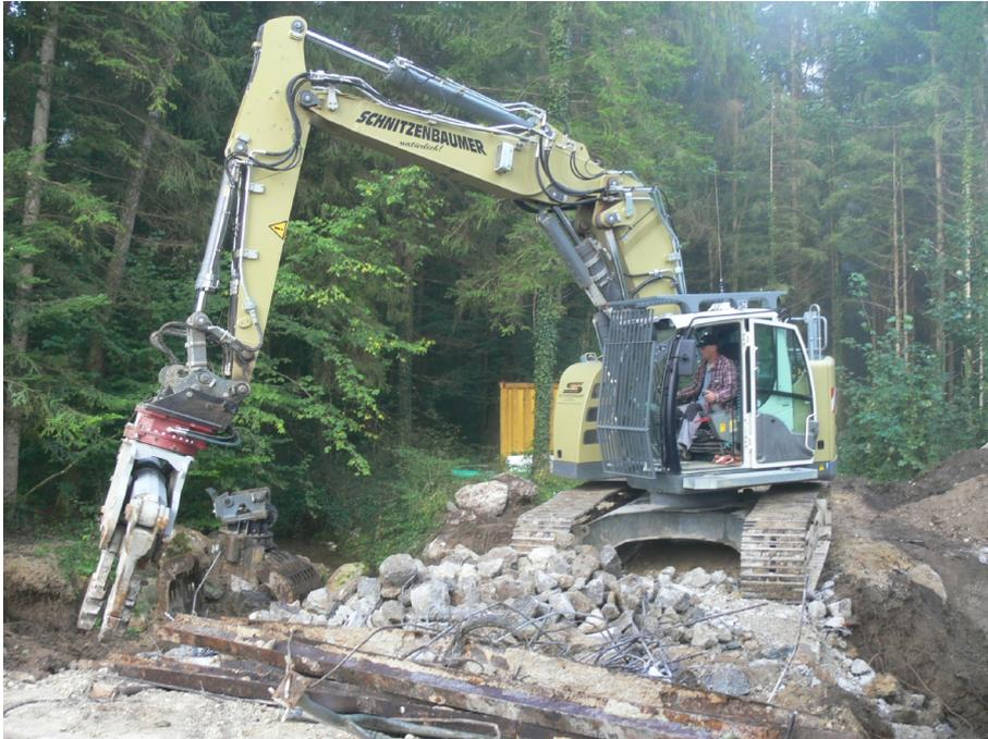
Abbildung 3: laufende Abbrucharbeiten am bestehenden Brückenbauwerk
