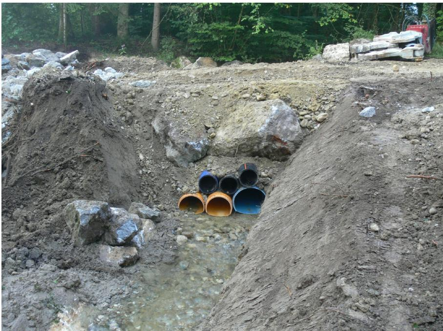
Abbildung 2: errichtete Gewässerumleitung mit Überfahrt und Durchleitungen, gegen Fließrichtung gesehen
