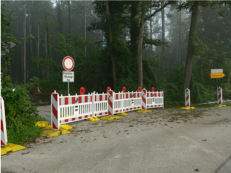
Abbildung 1: ordnungsgemäß abgesperrte Baustelle
