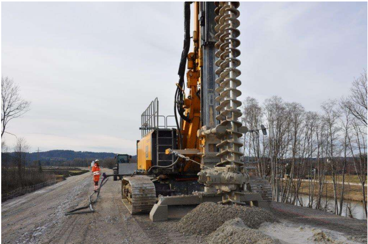
Abb. 2: Beispiel für Einsatz eines Mixed-in-Place (MIP) - Geräts am Trenndeich in Feldolling
