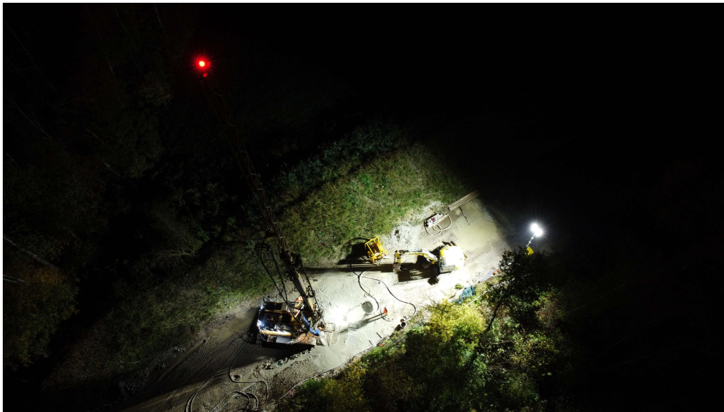
Abb. 1: Nachtbaubetrieb am Absperrdamm in Feldolling im Oktober 2022
