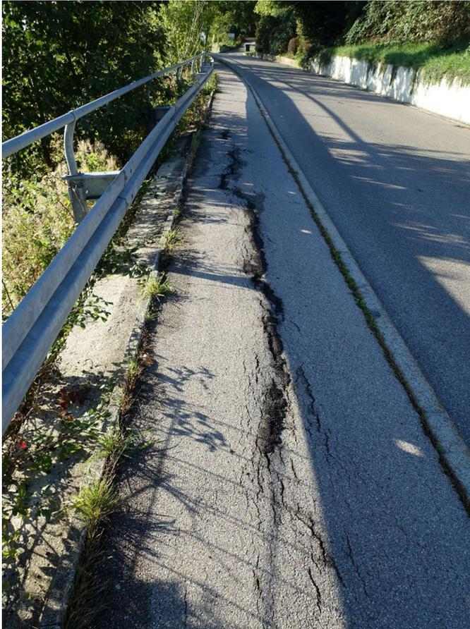
Sehr starke Beschädigung des Gehweges durch Hangrutsch
