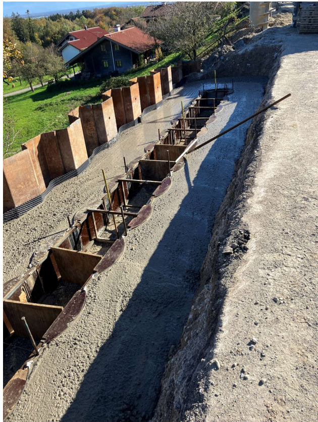
Während der Maßnahme
