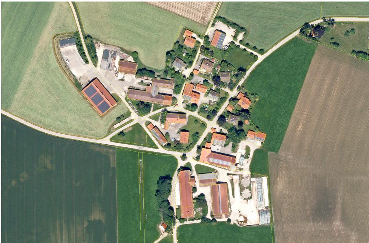
Abb. 7 Auszug aus Luftbild mit Aufnahmedatum vom 20.06.2020 – ohne Maßstab Quelle: BayernAtlas © 2021 StMFH; Geobasisdaten: © 2021 Bay. Vermessungsverwaltung
