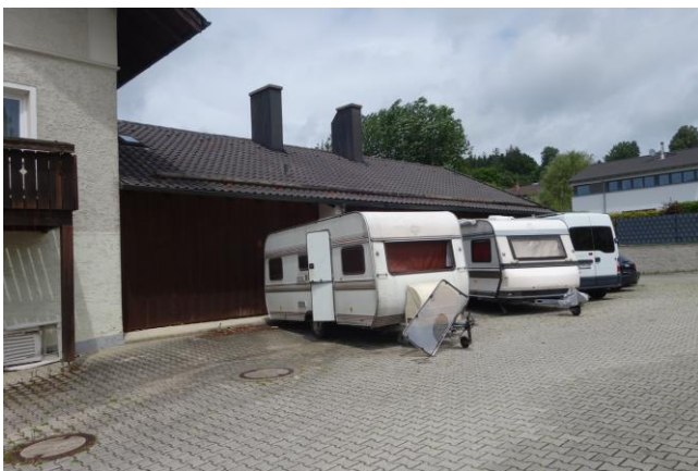
Abb. 9: Ansicht des Gebäudeteils B aus östlicher Richtung.
