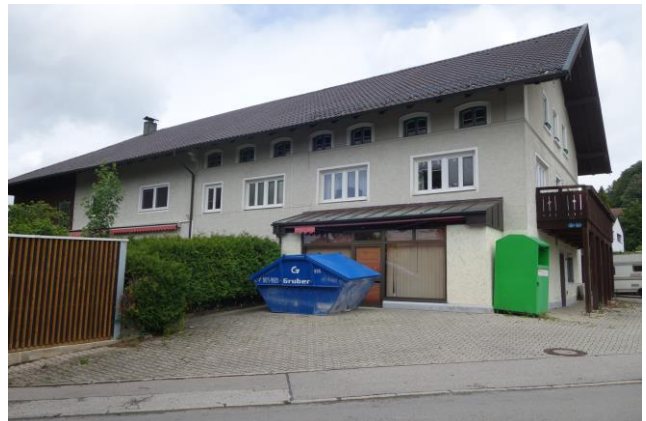
Abb. 4: Südansicht des Gebäudeteils A.
