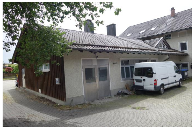
Abb. 10: Ansicht des Gebäudeteils B aus nördlicher Richtung.
