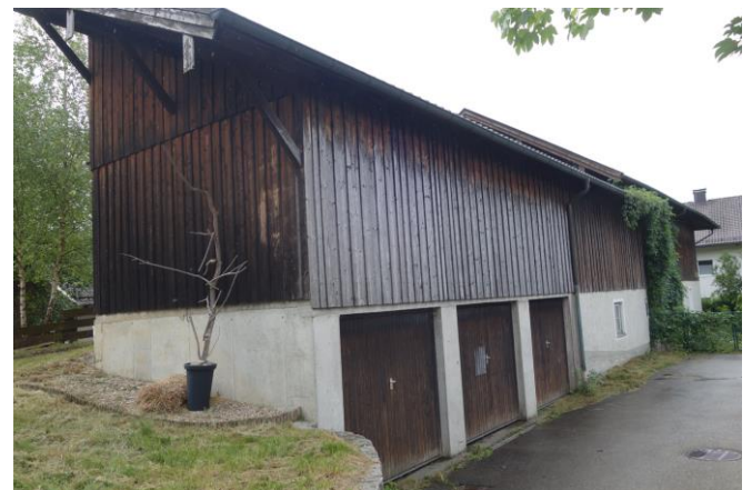
Abb. 16: Rückseite der Scheune, unterhalb des Anbaus befinden sich Garagen.
