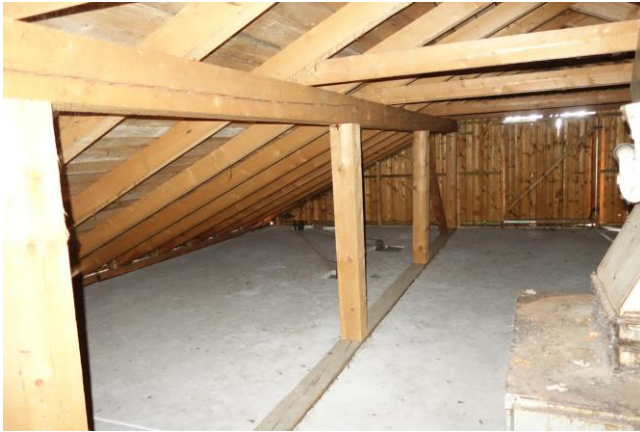
Abb. 7: Der Dachboden ist geschlossen und weist eine Einflugmöglichkeiten für Fledermäuse auf.
