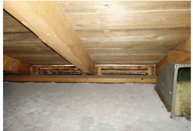
Abb. 8: Lüftungsschlitze sind mit Gittern verschlossen. Im Dachboden wurden keine i auf eine Nutzung durch Fledermäuse nachgewiesen
