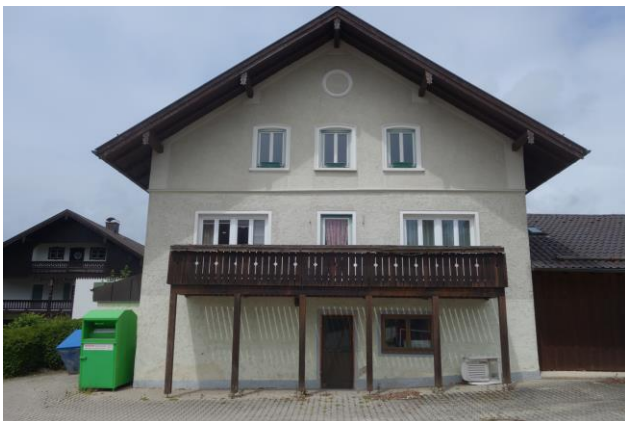
Abb. 3: Südostansicht Gebäudeteil A.
