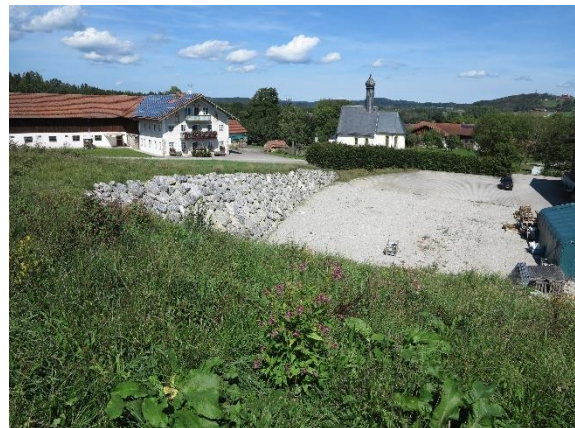
Abb. 6 Ansicht Stützmauer mit Blick von Süden
