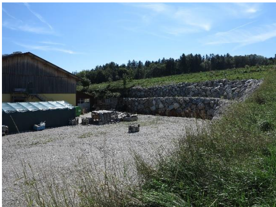
Abb. 5 Ansicht Stützmauer mit Blick von Norden
