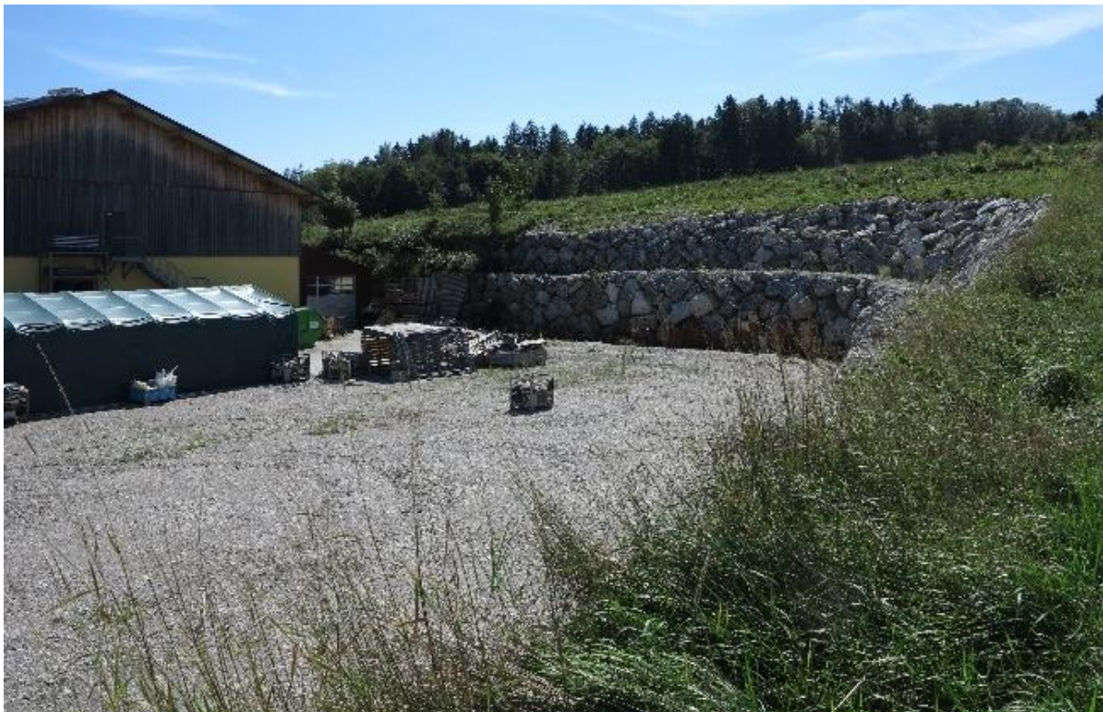
Abb. 5 Ansicht der Stützmauer mit Blick nach Norden
