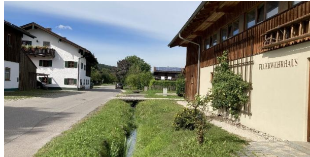
Abb. 11 Bachrenaturierung des Kotbachs vor dem Feuerwehrhaus (Hauptstr. 10) westlich (außerhalb) des Planungsgebiets (2020)
